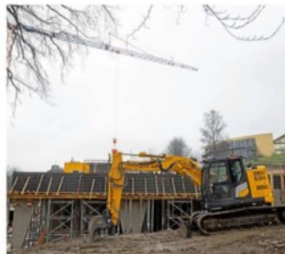
Der Kran der Baustelle der Grundschule Bleibergquelle bewältigt Lasten von bis zu 230 Tonnen. Im Hintergrund rechts die Christliche Gesamtschule.
