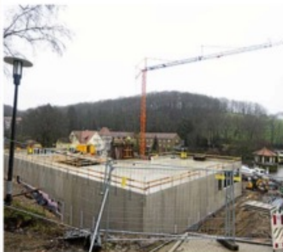
In den Hang gebaut wird die neue Grundschule der Bleibergquelle. Die Topographie bedeutet für Planer und auch Bauarbeiter eine besondere Herausforderung.
